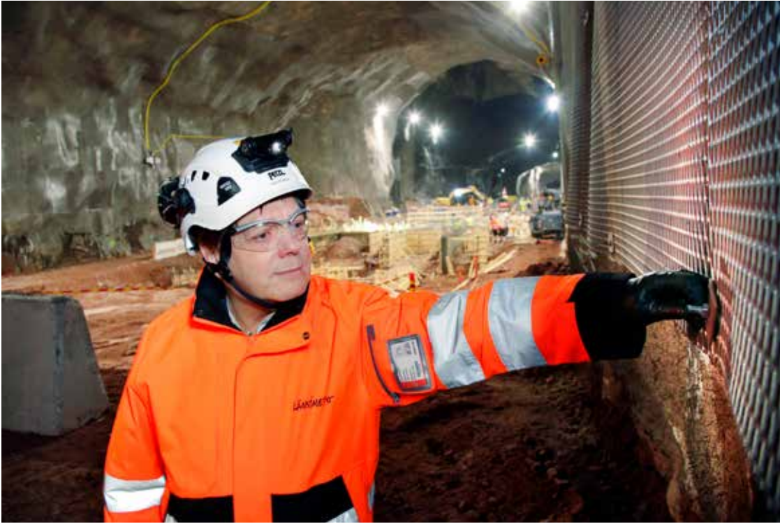
Länsimetron sähkövalvoja Ismo Penttinen liikkuu työpäivinänsä big roomin ja työmaiden välillä.
