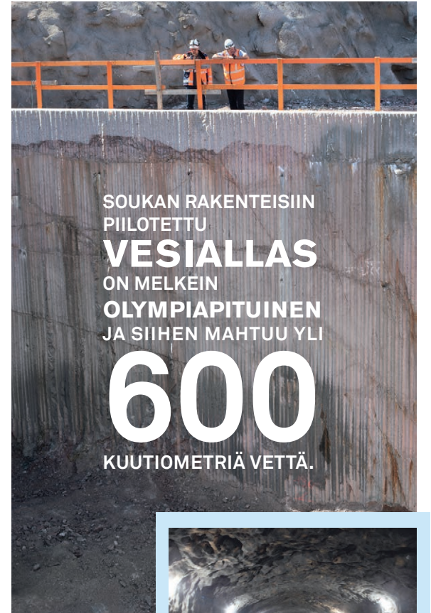
Jussi Kivikoura (vas.) ja Kimmo Hirvonen tarkastelevat luolastoa, johon rakentuu Soukan metroasema.
