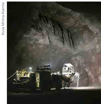
Soukan asemahallin louhintaa syyskuussa 2016.
