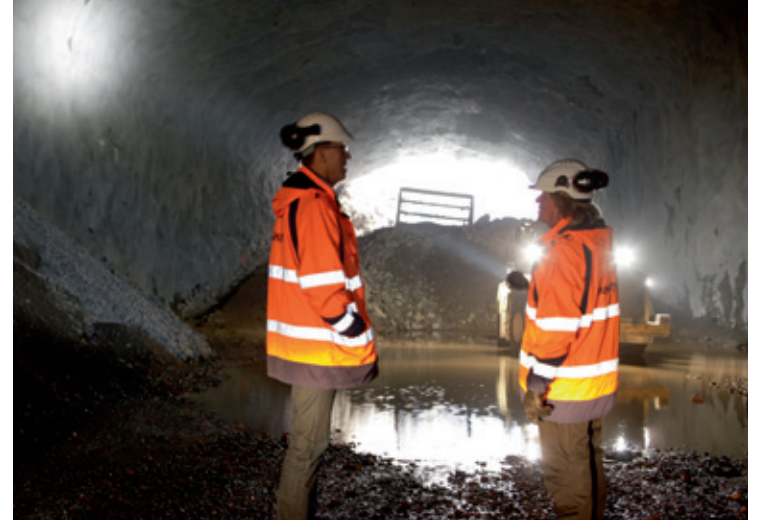
Projektipäällikkö Ahti Huhtaniska ja rakennustöiden valvoja Juha-Pekka Olli sovittavat työvaiheita ja logistiikkaa yhteen Tapiolassa.
