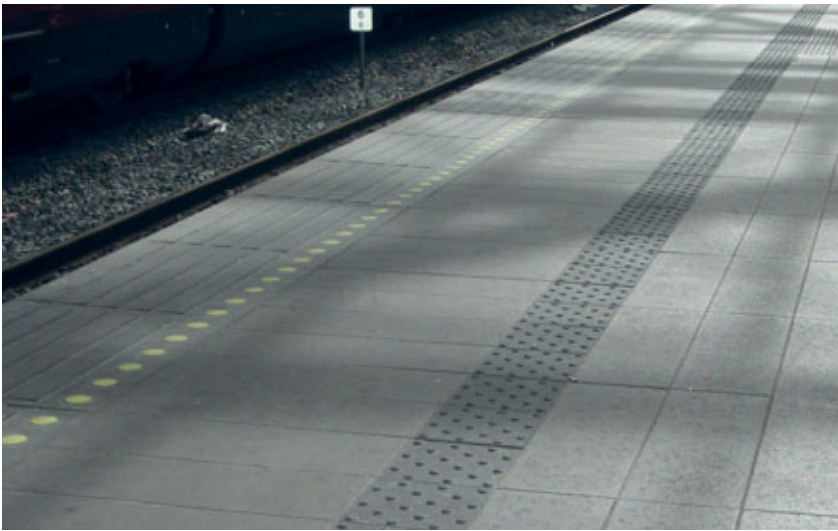
Esimerkki laiturin varoittavista pinnoitteista. Karhennettu pinnoiteraita on lähinnä reunaan ja varoittava raita hieman kauempana. Kuva Kööpenhaminasta
