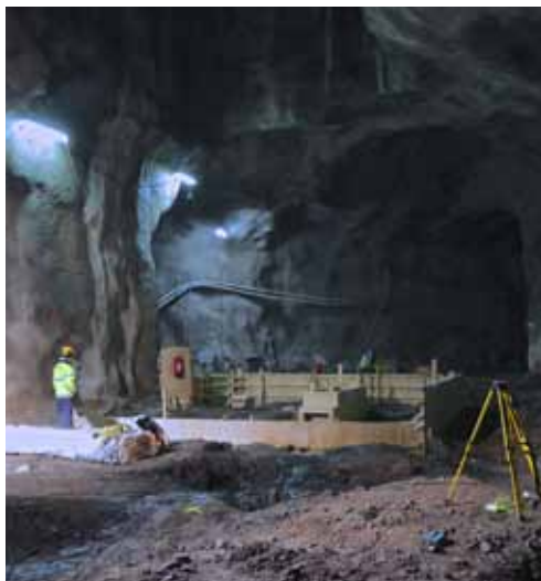
Tunnelin rakennusurakka on alkanut Ruoholahdessa.
