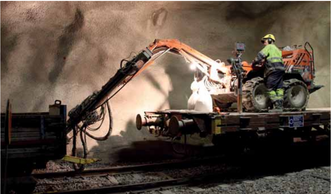
Ensimmäinen louhintaurakka kilpailutettiin alkusyksystä, ja keväällä ovat vuorossa useiden työtunnelien kilpailutukset.
