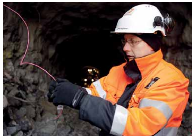
Työmaapäällikkö Jarkko Hyttiäinen näyttää, kuinka räjähteet yhdistetään toisiinsa värikkäillä sytytyslangoilla.
